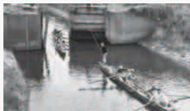
銚子遠漕・利根運河(二里八丁)水門(昭和36年頃)
