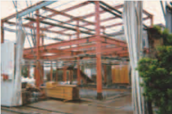
埼玉 戸田合宿所工事(1991年)
